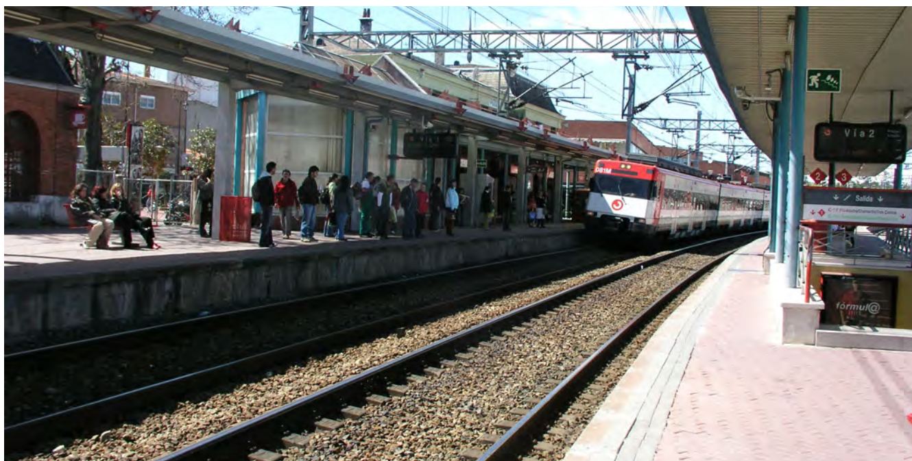
Vista de la Estación de tren
