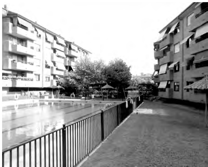
Urbanización cerrada (calle Pablo VI).
